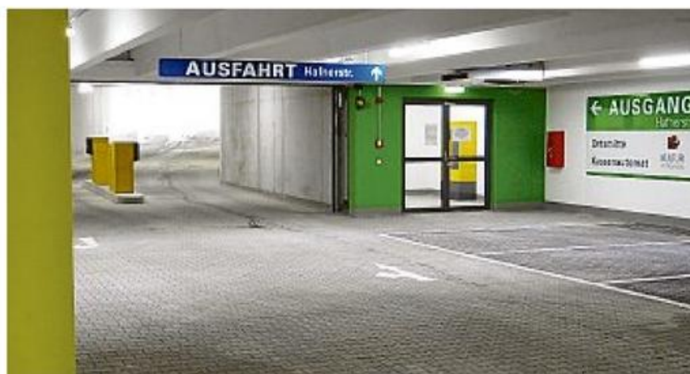
Farbig, hell, freundlich: Die neue Holzkirchner Tiefgarage bietet Platz für 196 Fahrzeuge und punktet auch mit der optischen Gestaltung.
